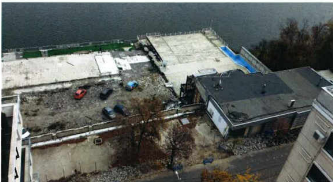
Figură 7: Poze - Poze Asociatia de locatari Estia Residence - A se observa extinderea cladirilor deasupra apei, pe proprietatea lacului -
